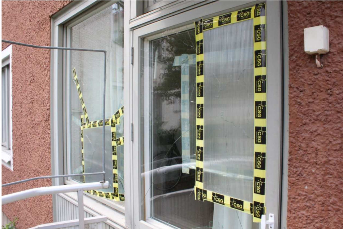
Figur 21. Visar de krossade glasrutorna i ett av vardagsrummets fönster och i balkongdörren. Fönsterglasen har lagats provisoriskt med skyddsplast och tejp.
